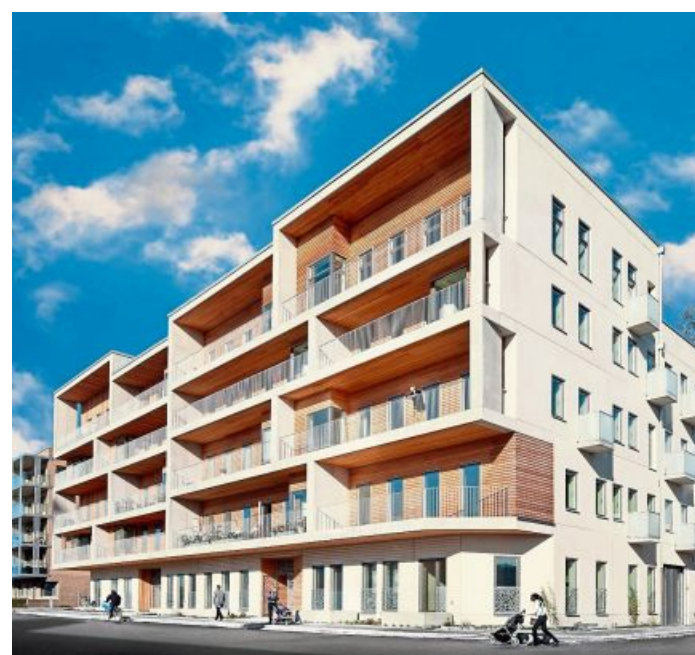
Ein Wohnhaus von White Arkitekten in Malmö.
